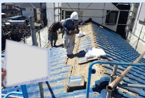
K様邸外壁改修工事
