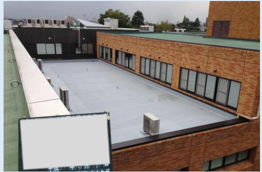
大学入試センター本館屋上 防水改修工事
