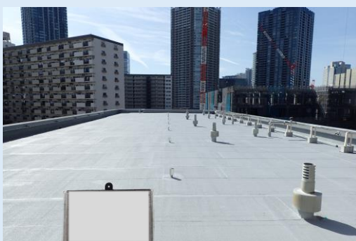
都営塩浜一丁目住宅屋上防水工事
