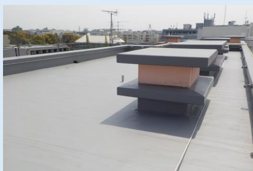
蒲田医療センター 屋上防水改修整備工事(萩中宿舎)
