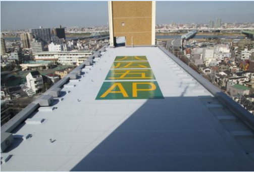
都営八広五丁目アパート屋上防水工事
