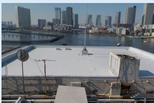
東京海洋大学（越中島） 第4実験棟屋上防水改修工事
