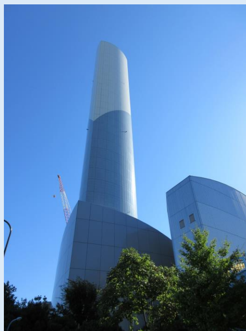
港清掃工場延命化に伴う煙突外壁改修工事
