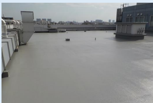
蒲田医療センター 屋上防水改修整備工事(診療棟)
